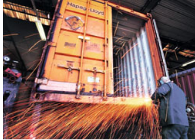
Ob Umbau oder Reparatur: HCCR kennt sich aus mit Containern.
