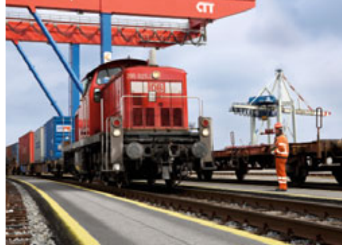
Neuer Containerbahnhof des CTT: Kapazität vervünffacht.
